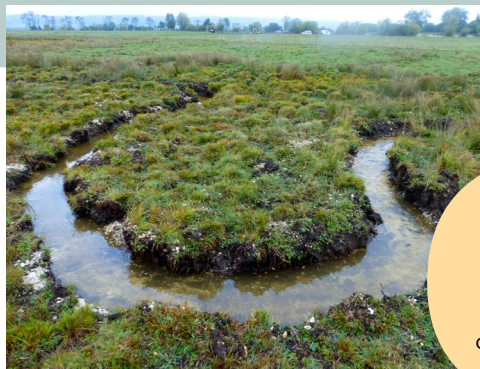
Travaux de reméandrage
